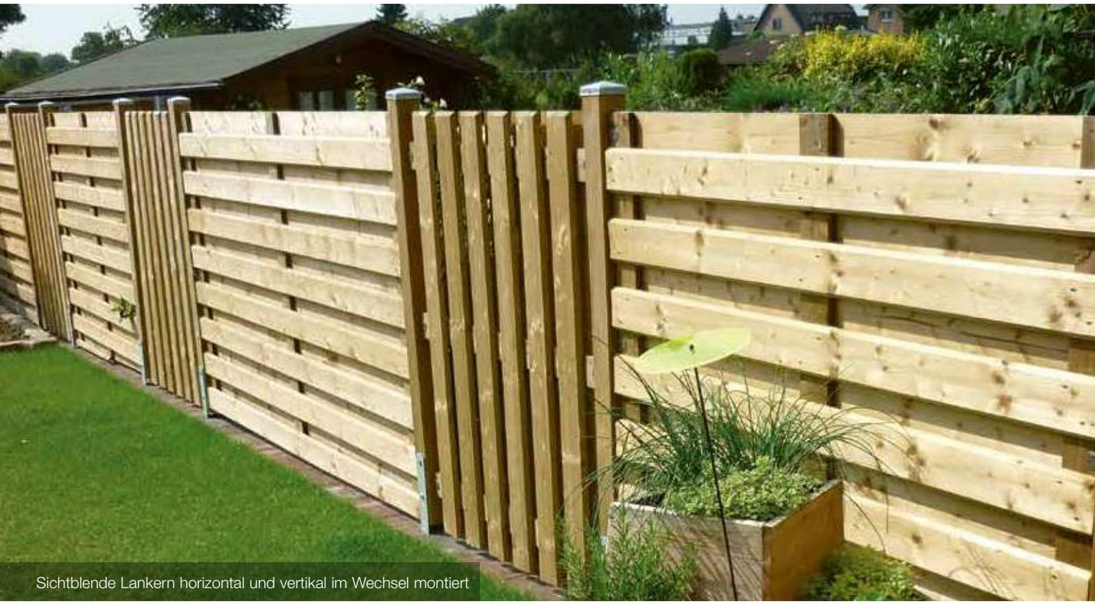
Sichtblende Lankern horizontal und vertikal im Wechsel montiert
